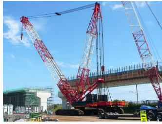
大型重機（建機）
